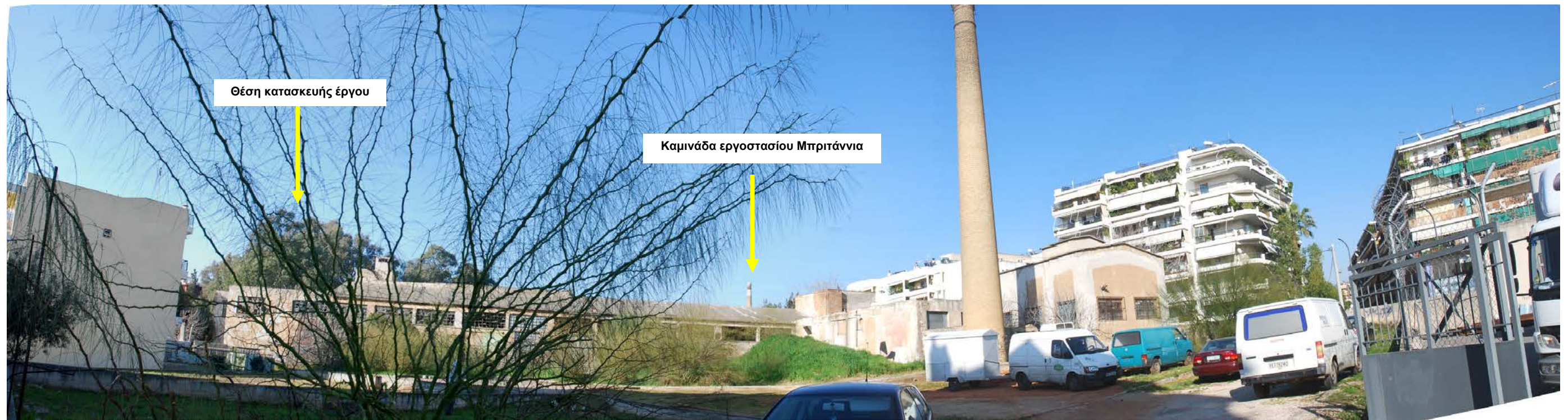
Φωτ. 25 Άποψη του εργοστασίου Βαμβακουργία από τα νότια. Σημειώνεται η θέση του εργοστασίου Μπριτάννια, όπως επίσης και η θέση κατασκευής του έργου. Λόγω της υψηλής βλάστησης δεν υπάρχει οπτική επαφή με τη θέση του γηπέδου
