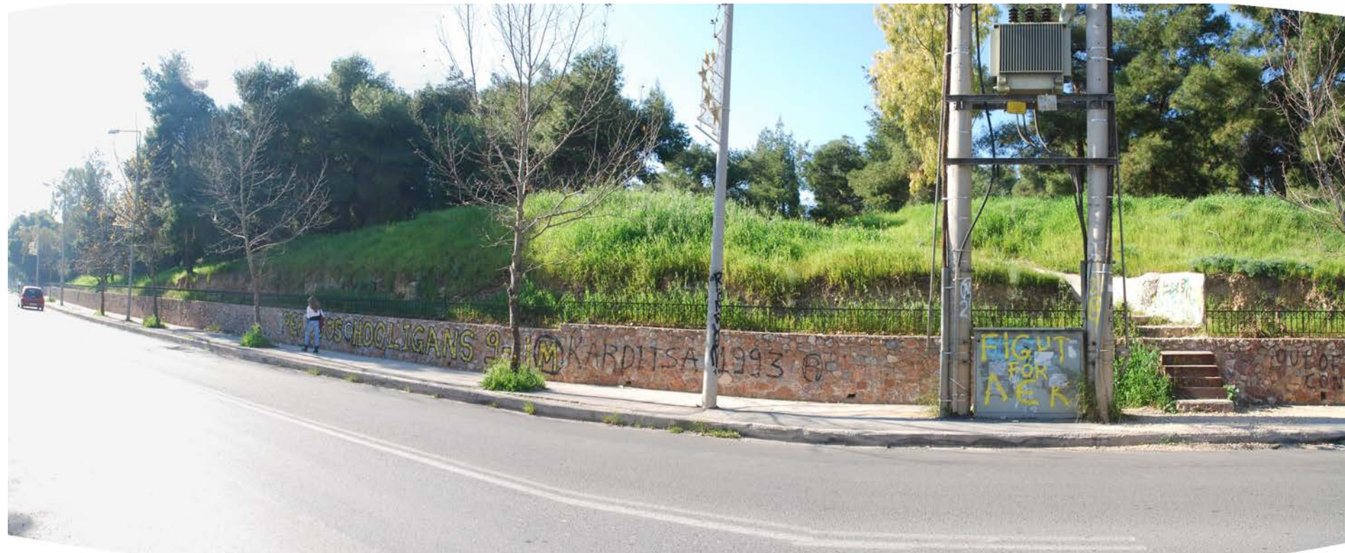
Φωτ. 15 Άποψη του περιοχής του άλσους της Νέας Φιλαδέλφειας από την Πατριάρχου Κωνσταντίνου
