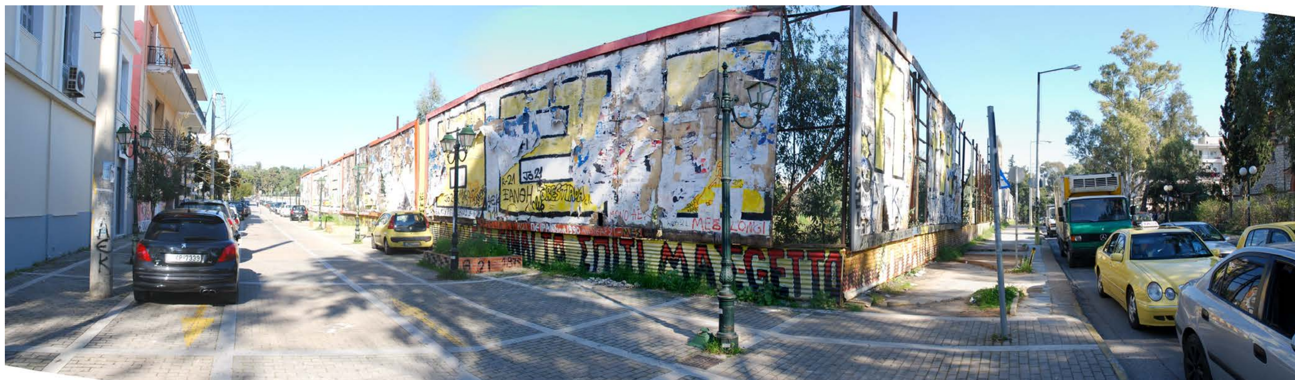
Φωτ. 1 Άποψη της περιοχής ανάπτυξης του Κέντρου Αθλητισμού Μνήμης και Πολιτισμού Αγία Σοφία από τη συμβολή των οδών Φωκών και Κατπαδοκίας
